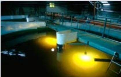
水下照明系统 正确使用水下照明系统可控制冷水水产 养殖中鱼类的成熟、加快鱼类的成长并 提高饲料利用率。
